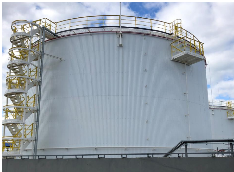
Рисунок 1 - Общий вид резервуара стального вертикального цилиндрического РВС-5000
