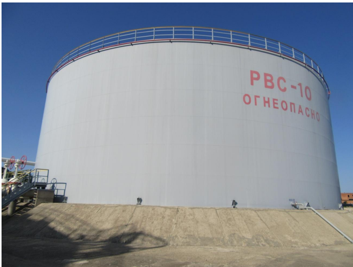
Рисунок 2 - Общий вид резервуара № 10
