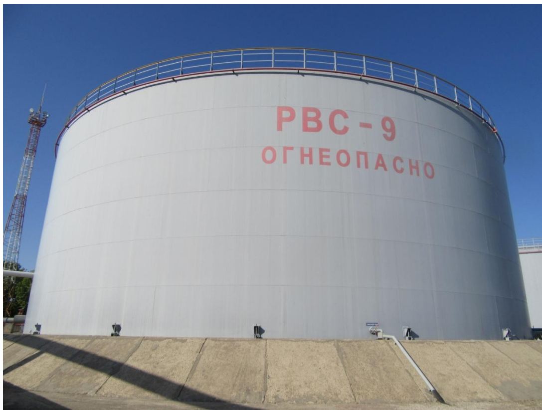
Рисунок 1 - Общий вид резервуара № 9
