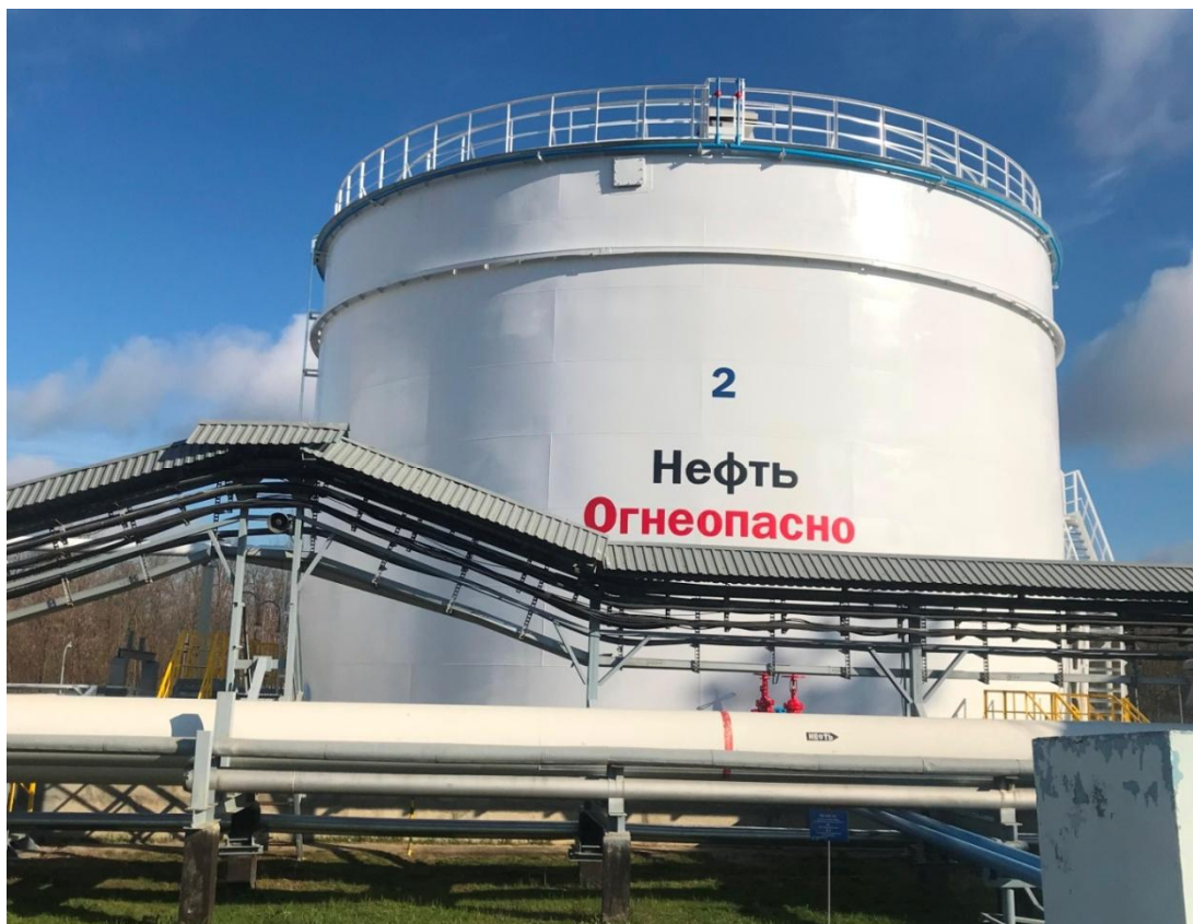
Рисунок 2 - Общий вид резервуара № 2
