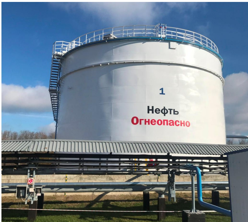
Рисунок 1 - Общий вид резервуара № 1
