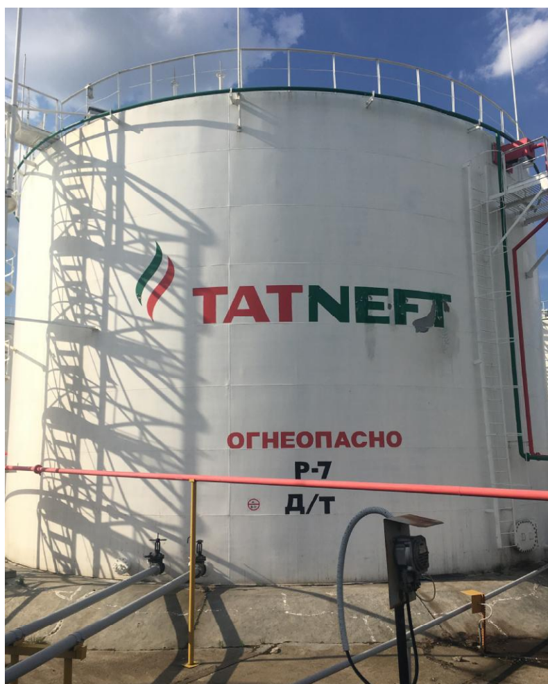
Рисунок 1 - Общий вид резервуара РВС-3000
