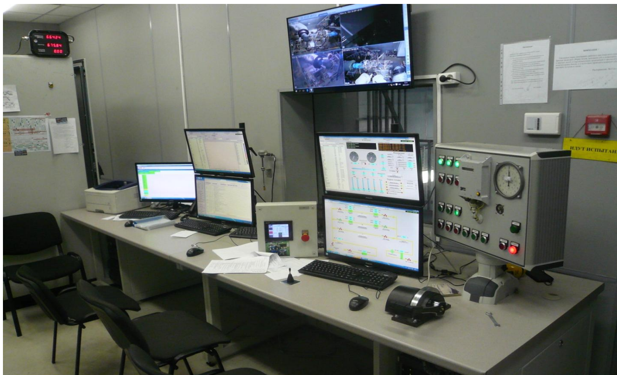
Рисунок 3 - Автоматизированное рабочее место пульта управления
