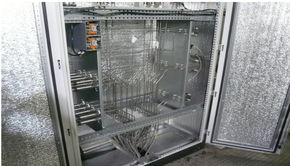
Рисунок 1 - Шкаф измерительных преобразователей
