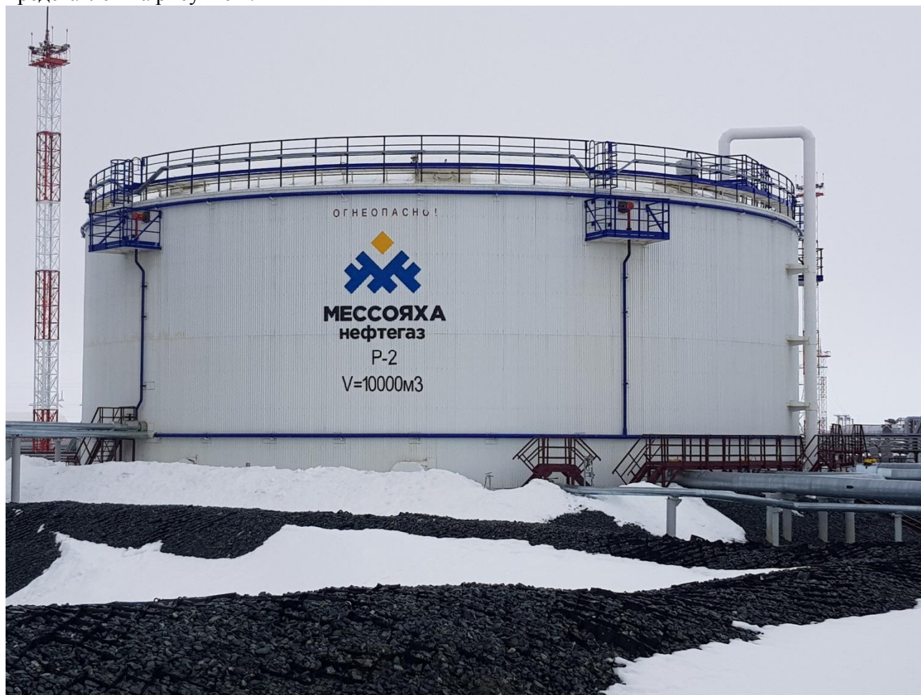
Рисунок 1 – Общий вид резервуара РВС-10000
