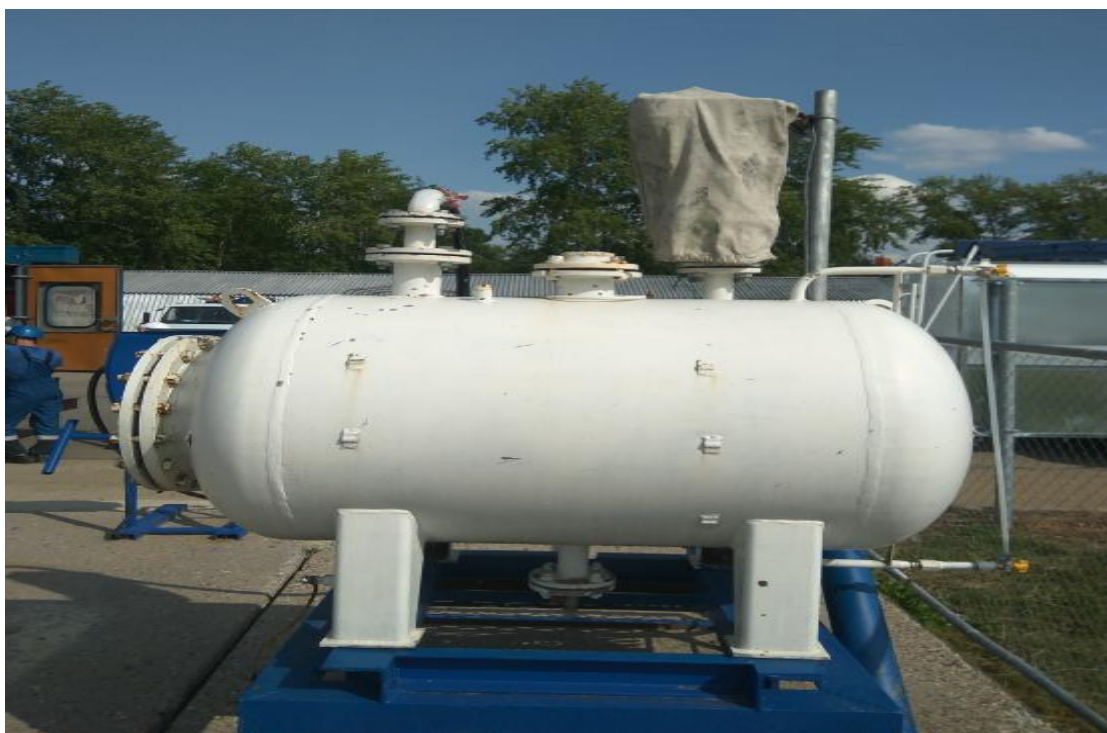
Рисунок 1 – Общий вид резервуара РГС-0,630
