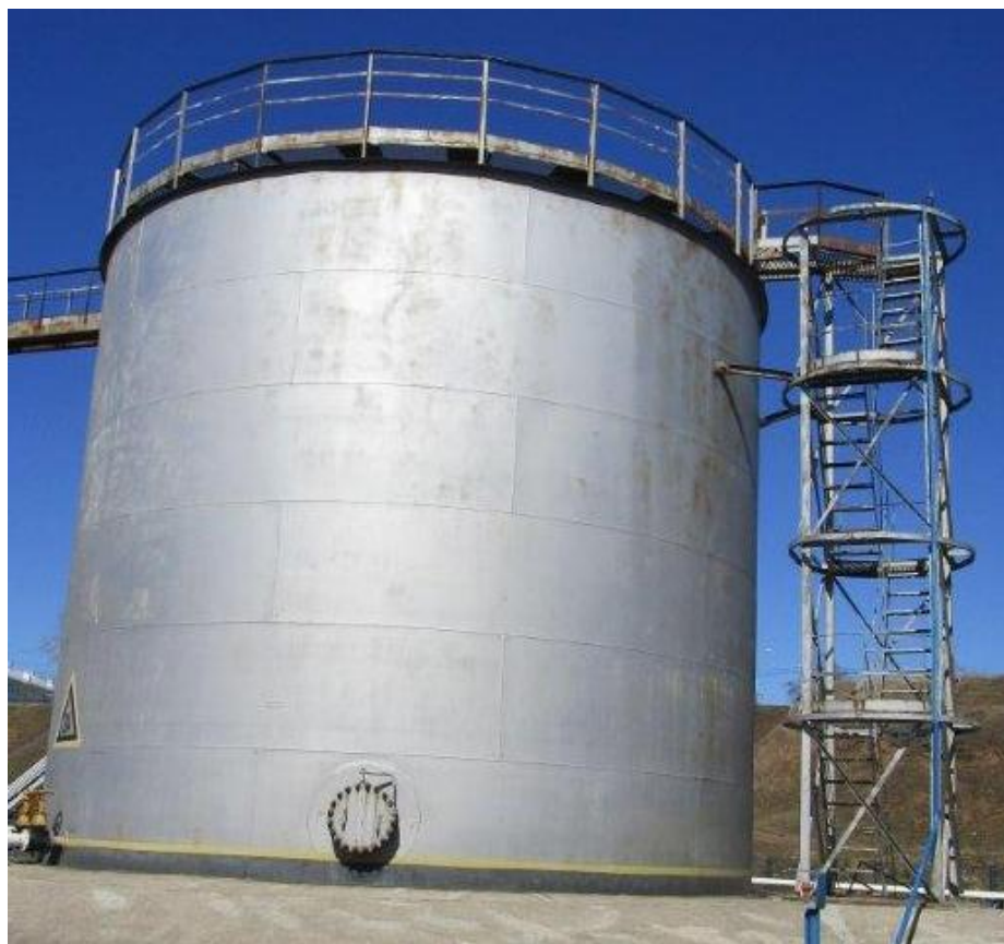
Рисунок 1 – Общий вид резервуара вертикального стального цилиндрического РВС-700.
