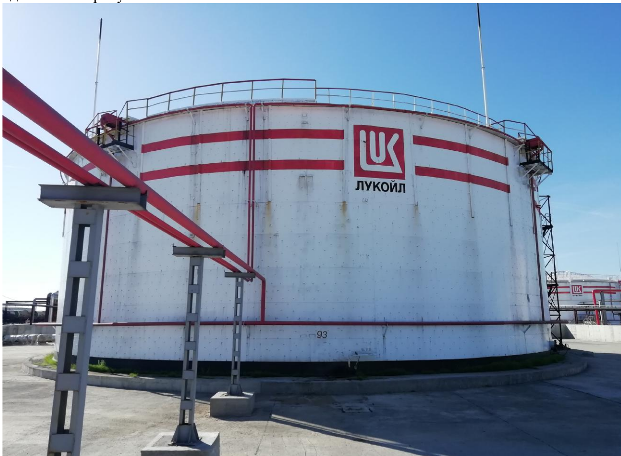
Рисунок 1 – Общий вид резервуара РВС-10000
