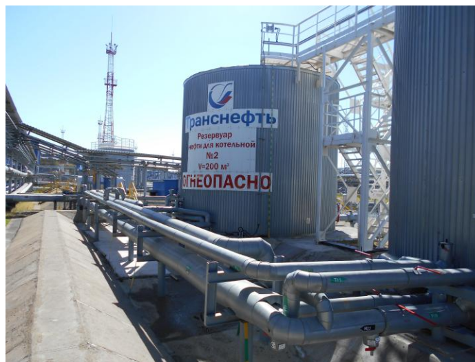
Рисунок 2 - Общий вид резервуара РВС-200 № 108.2
