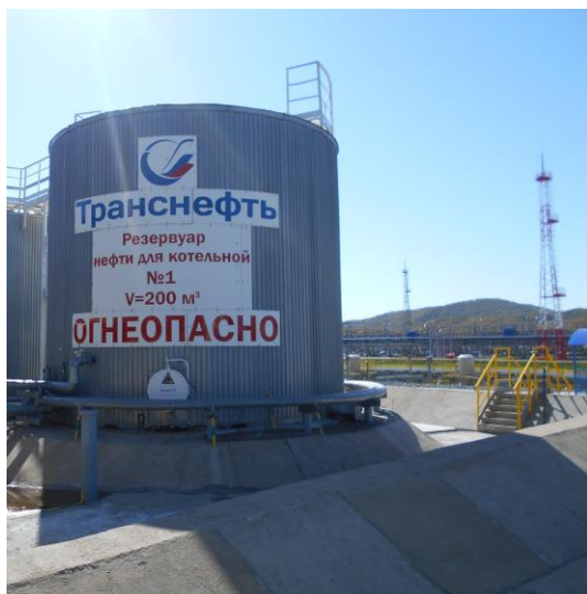
Рисунок 1 - Общий вид резервуара РВС-200 № 108.1
