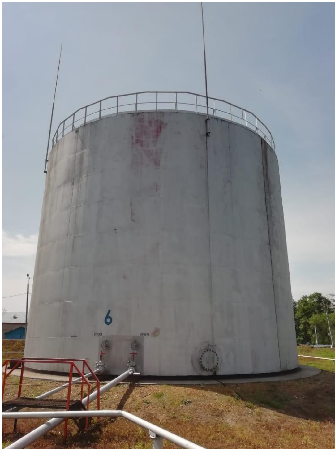
Рисунок 1 – Общий вид резервуара стального вертикального цилиндрического РВСП-2000
