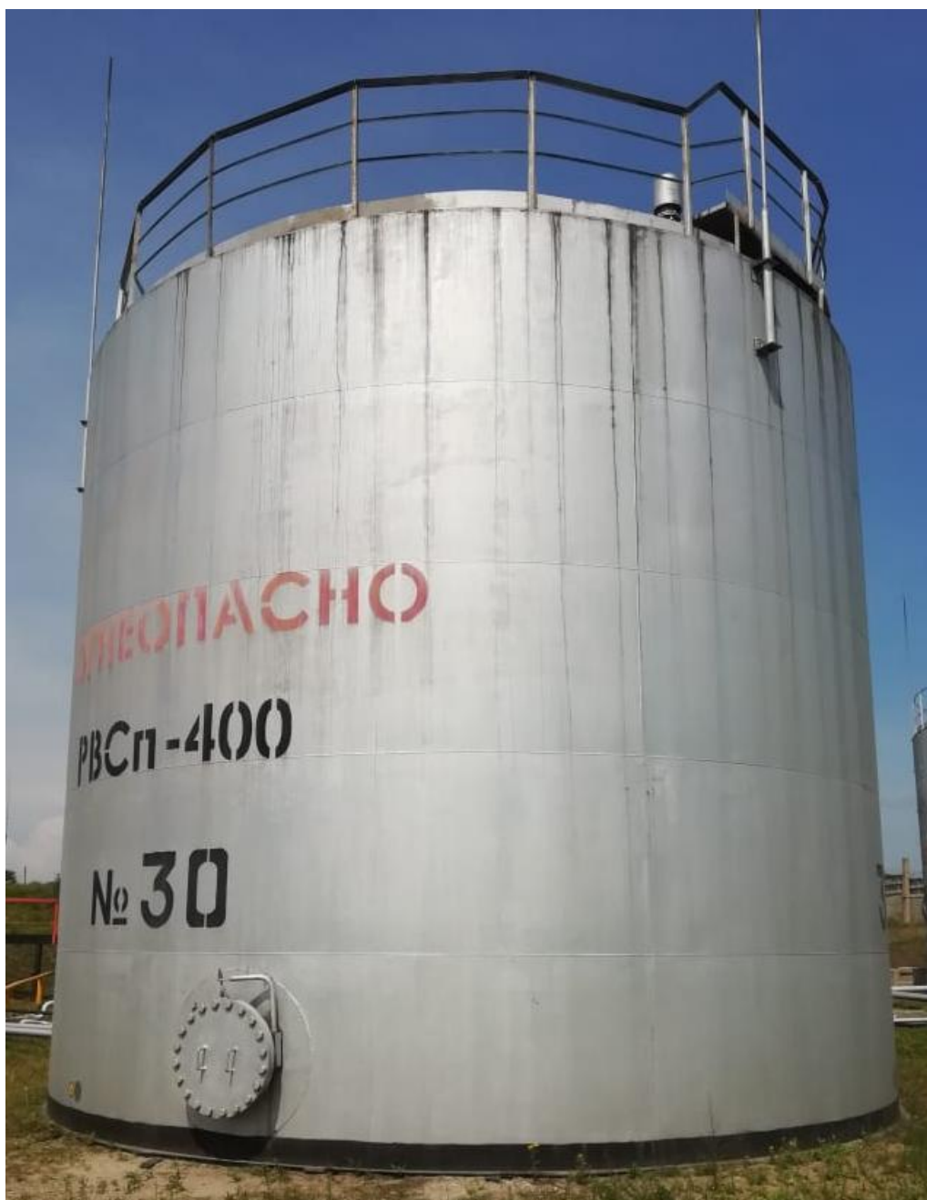
Рисунок 1 – Общий вид резервуара стального вертикального цилиндрического РВСП-400
