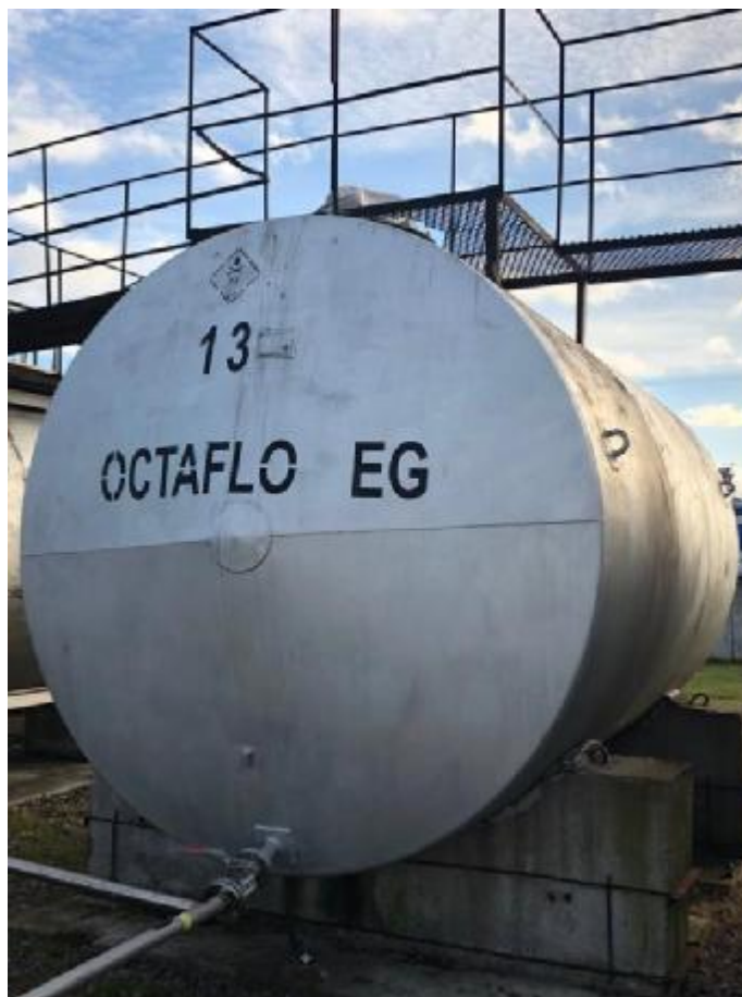
Рисунок 1 – Общий вид резервуаров РГС-25
