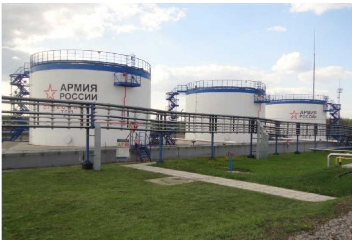
Рисунок 1 – Общий вид резервуаров стальных вертикальных цилиндрических РВС-1629
