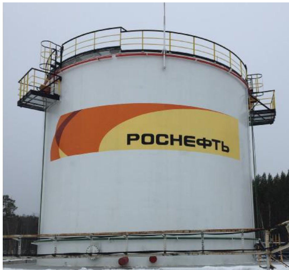
Рисунок 1 – Общий вид резервуара стального вертикального цилиндрического РВС-2000
