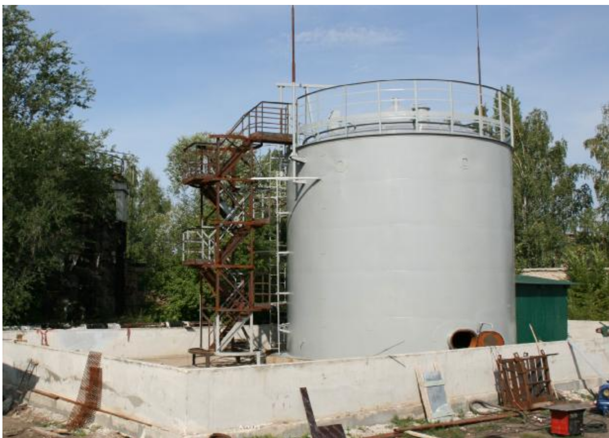
Рисунок 1 - Резервуар вертикальный стальной РВС-400 №1К
