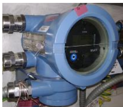
Рисунок 1 – Схема пломбировки счетчика-расходомера массового Micro Motion модели CMF200 с измерительным преобразователем 2700
