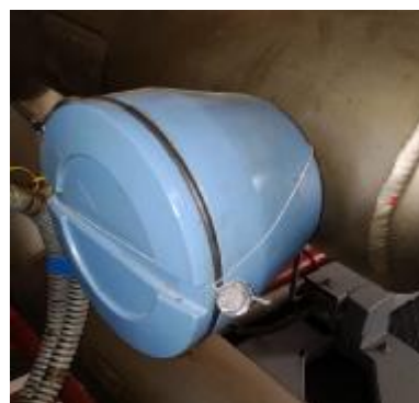
Рисунок 1 – Схема пломбировки счетчика-расходомера массового Micro Motion модели CMF200 с измерительным преобразователем 2700
