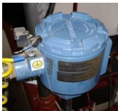
Рисунок 3 – Схема пломбировки термопреобразователя сопротивления платинового серии 65 в комплекте с преобразователем измерительным 144 к датчикам температуры и с преобразователем измерительным 244 к датчикам температуры
