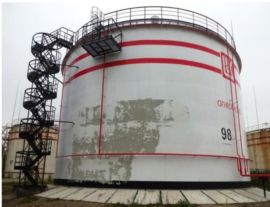
Рисунок 1 – Общий вид резервуара РВСП-5000 № 98
