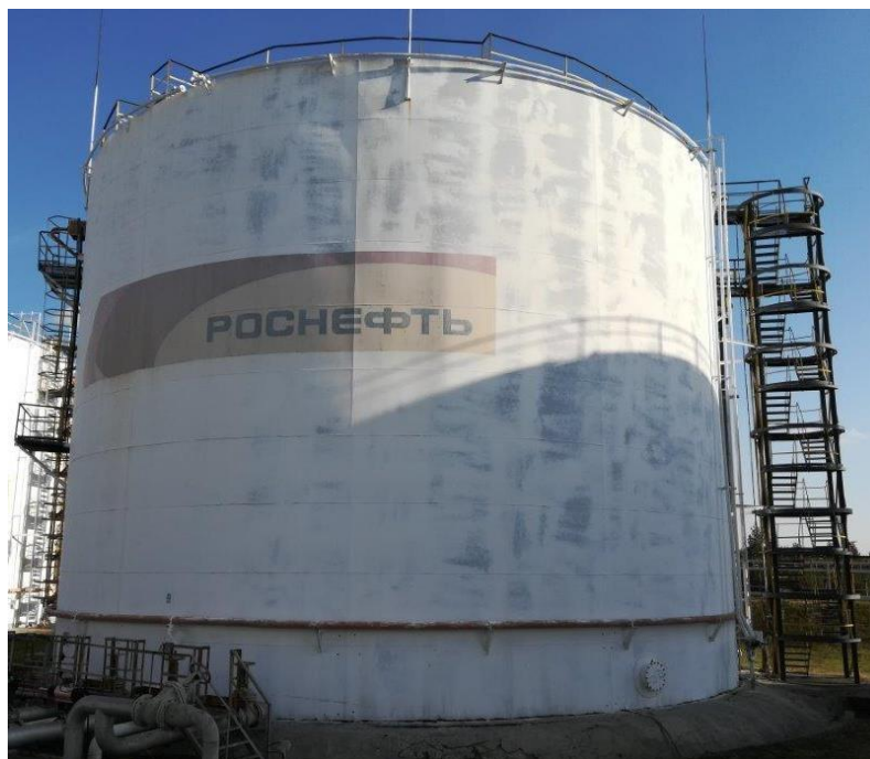
Рисунок 4 – Общий вид резервуара стального вертикального цилиндрического РВСП-5000
