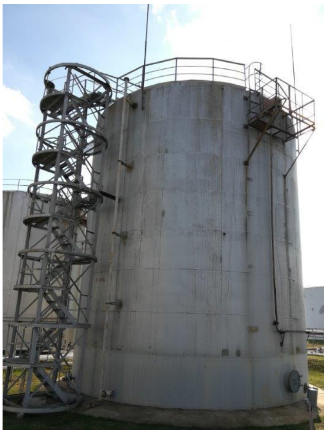
Рисунок 2 – Общий вид резервуара стального вертикального цилиндрического РВСП-1000
