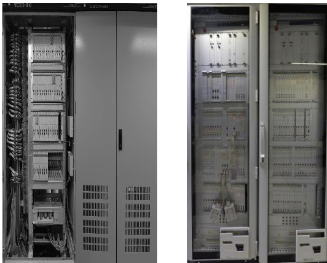
Рисунок 1 - Общий вид электротехнических шкафов ИС УСБТ (со средствами программно-техническими ТПТС-ЕМ - слева, с измерительными компонентами из состава КТС НПЛ - справа)
