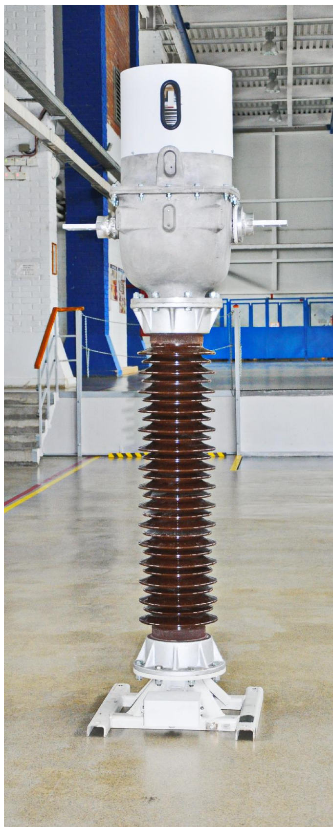
Рисунок 1 – Общий вид трансформаторов тока ТОМ-110 III
