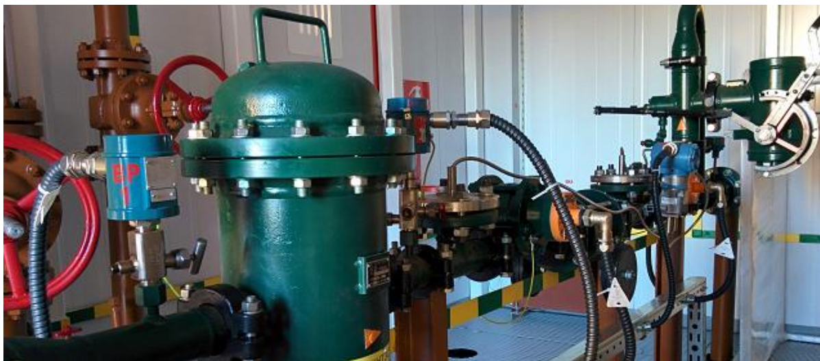
Фото 3 - Общий вид измерительной линии установки
