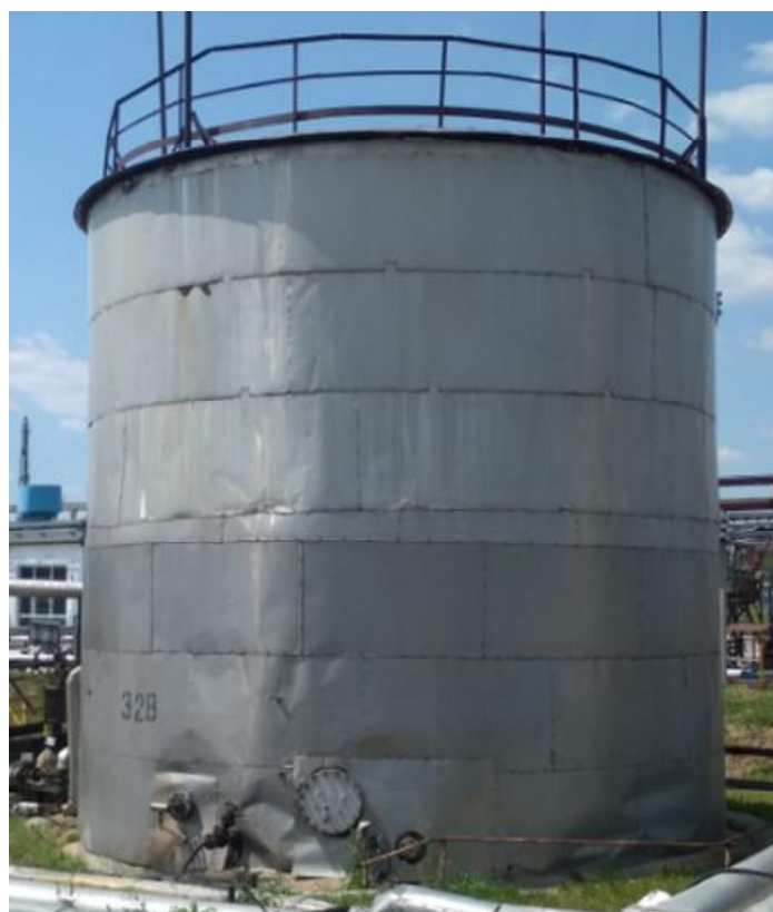
Рисунок 3 – Общий вид резервуара стального вертикального цилиндрического РВС-300
