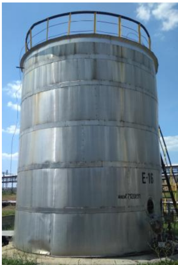
Рисунок 1 – Общий вид резервуара стального вертикального цилиндрического РВС-100
