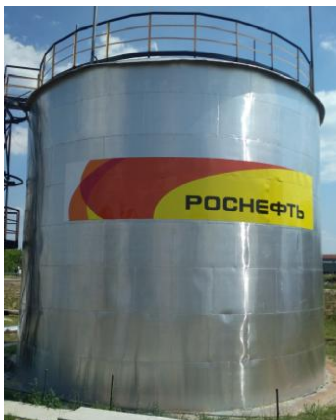
Рисунок 5 – Общий вид резервуара стального вертикального цилиндрического РВС-700
