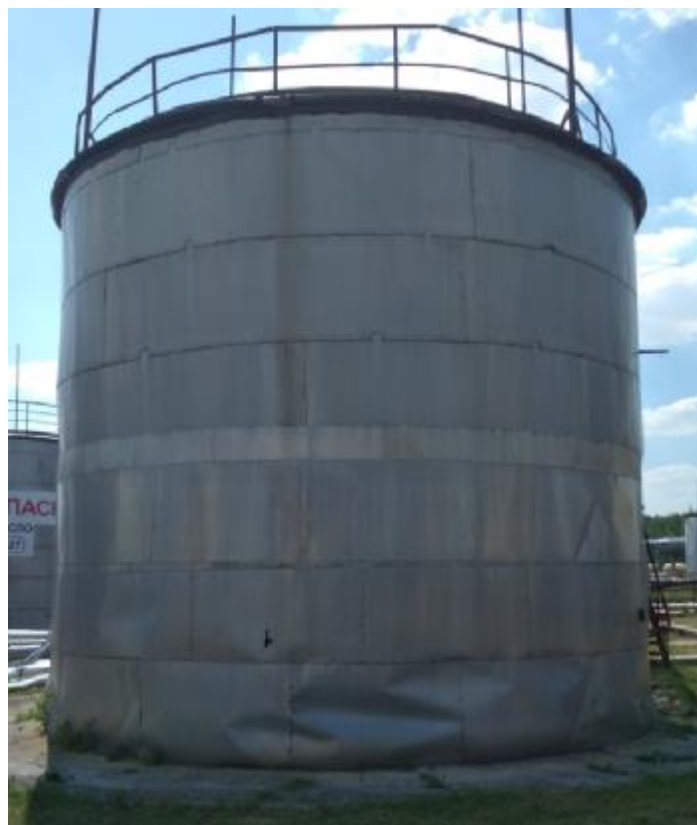
Рисунок 4 – Общий вид резервуара стального вертикального цилиндрического РВС-400
