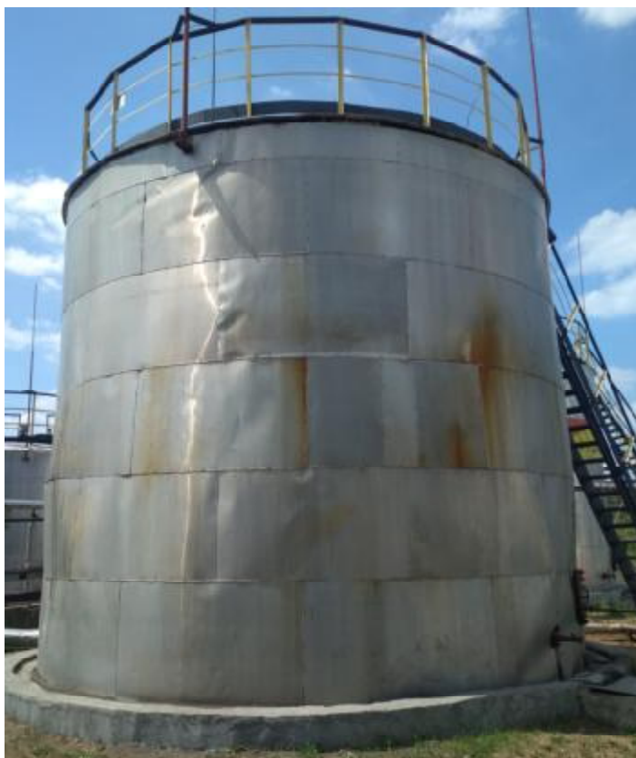
Рисунок 2 – Общий вид резервуара стального вертикального цилиндрического РВС-200
