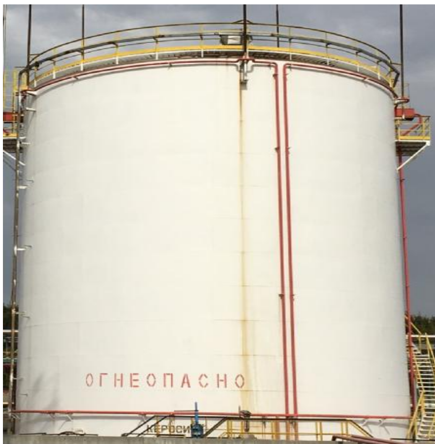
Рисунок 1 – Общий вид резервуара стального вертикального цилиндрического РВС-3000
