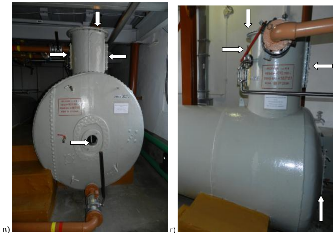
Рисунок 2 – Схема пломбировки мерников ММГ от несанкционированного доступа а) заводской № 8179, б) заводской №1, в) заводской №2, г) заводской №4
