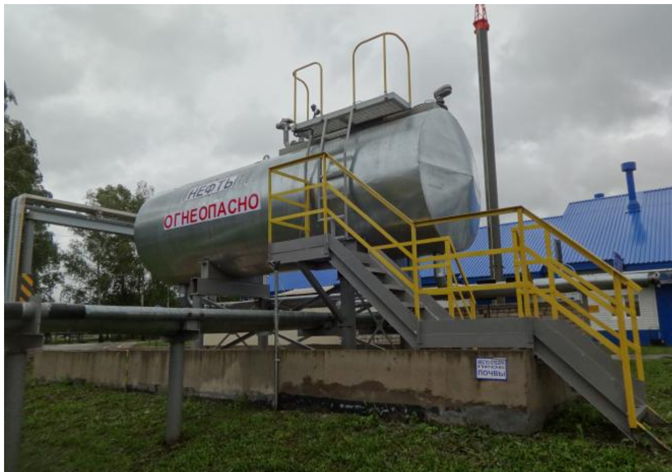
Рисунок 1 – Общий вид резервуара РГС-20
