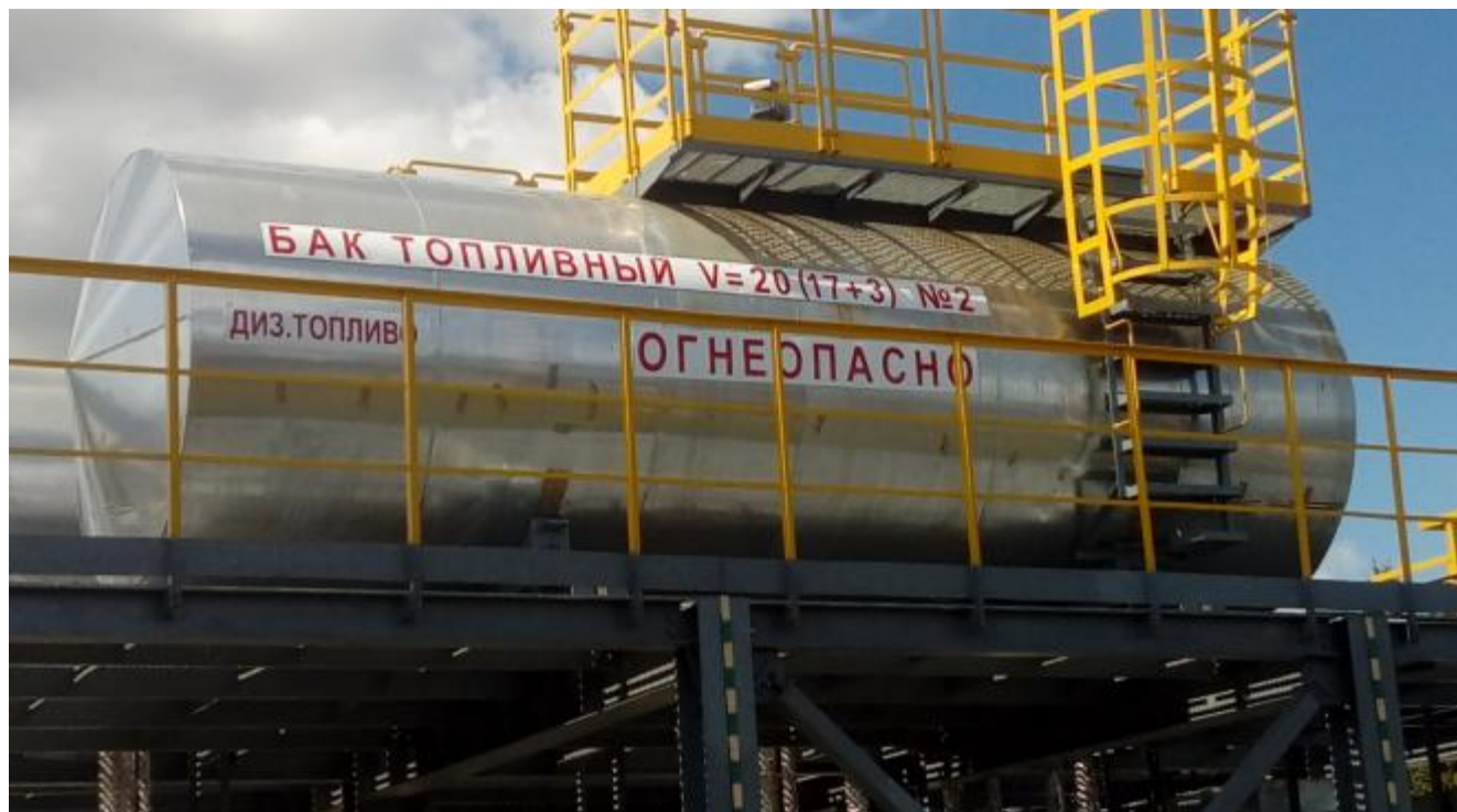
Рисунок 1 – Общий вид резервуара РГС-20
