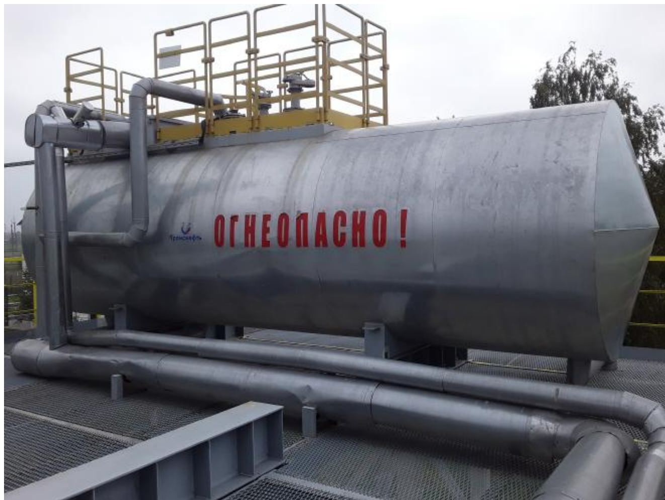
Рисунок 1 – Общий вид резервуара РГС-20
