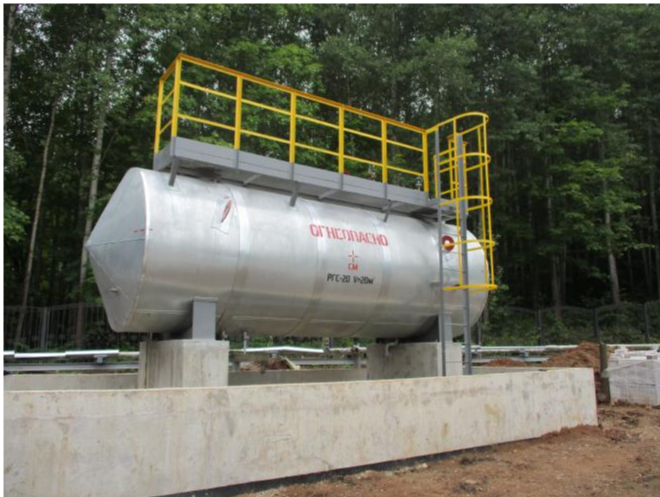
Рисунок 1 – Общий вид резервуара РГС-20
