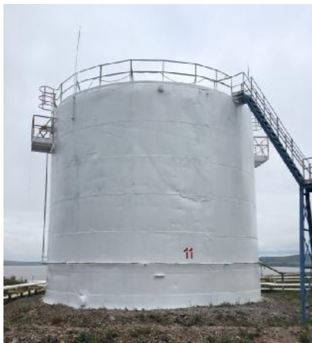
Рисунок 2 – Общий вид резервуара РВС-1000 заводской № 11
