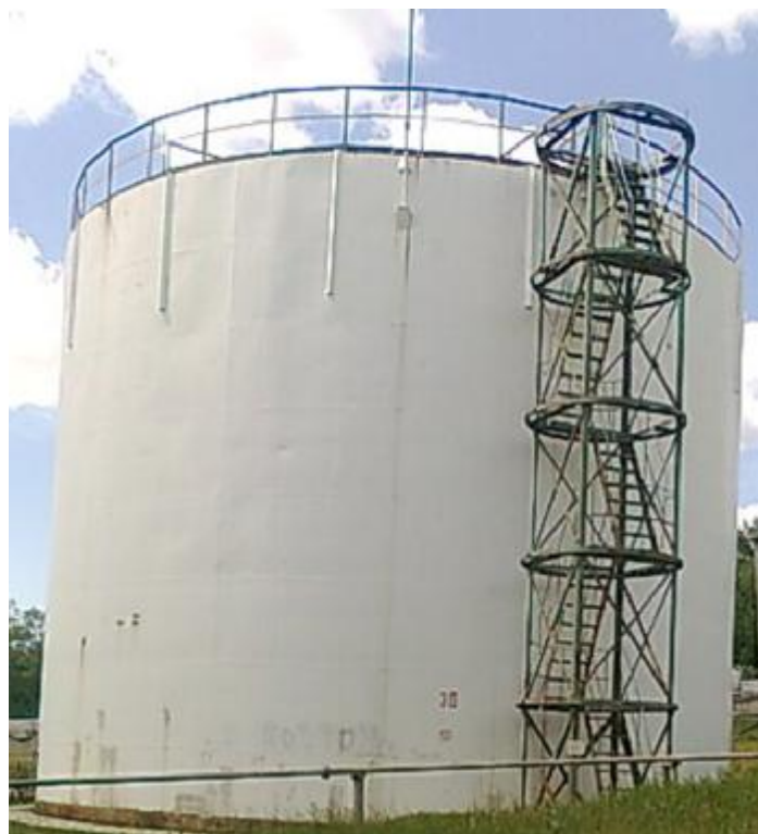
Рисунок 3 – Общий вид резервуара стального вертикального цилиндрического РВС-2000, РВСП-2000
