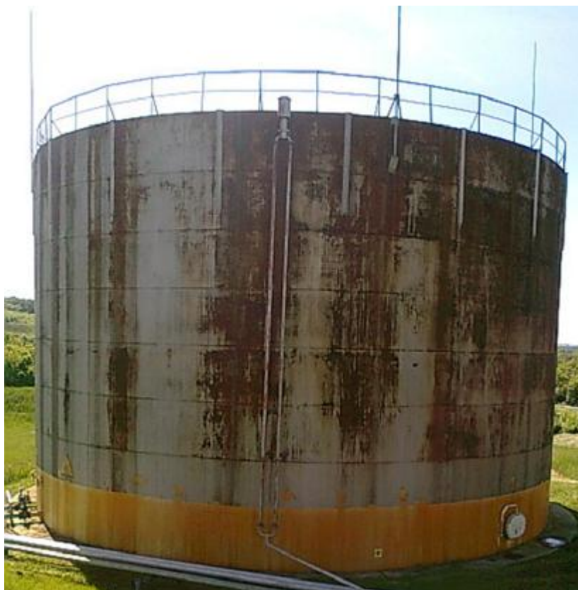
Рисунок 4 – Общий вид резервуара стального вертикального цилиндрического РВС-3000
