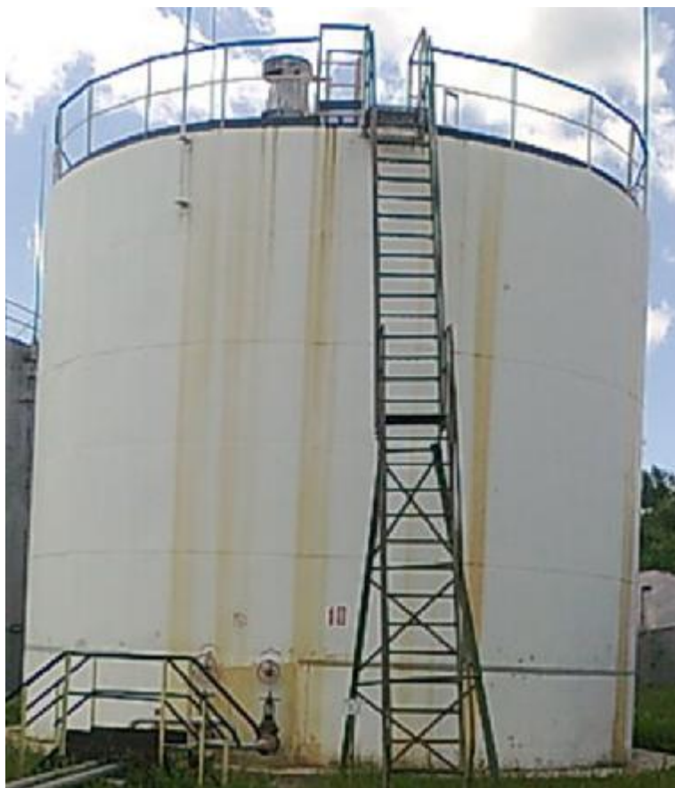
Рисунок 1 – Общий вид резервуара стального вертикального цилиндрического РВС-700
