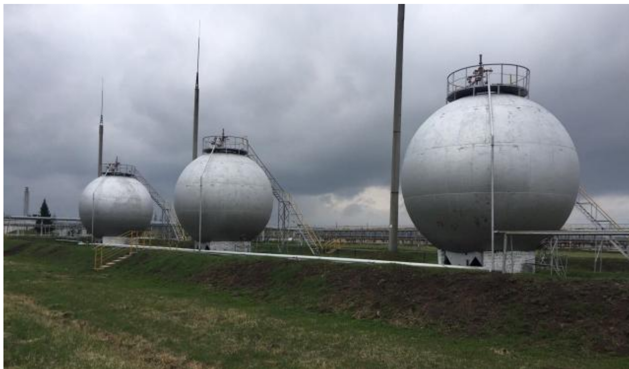
Рисунок 1 – Общий вид резервуаров РШС-600
