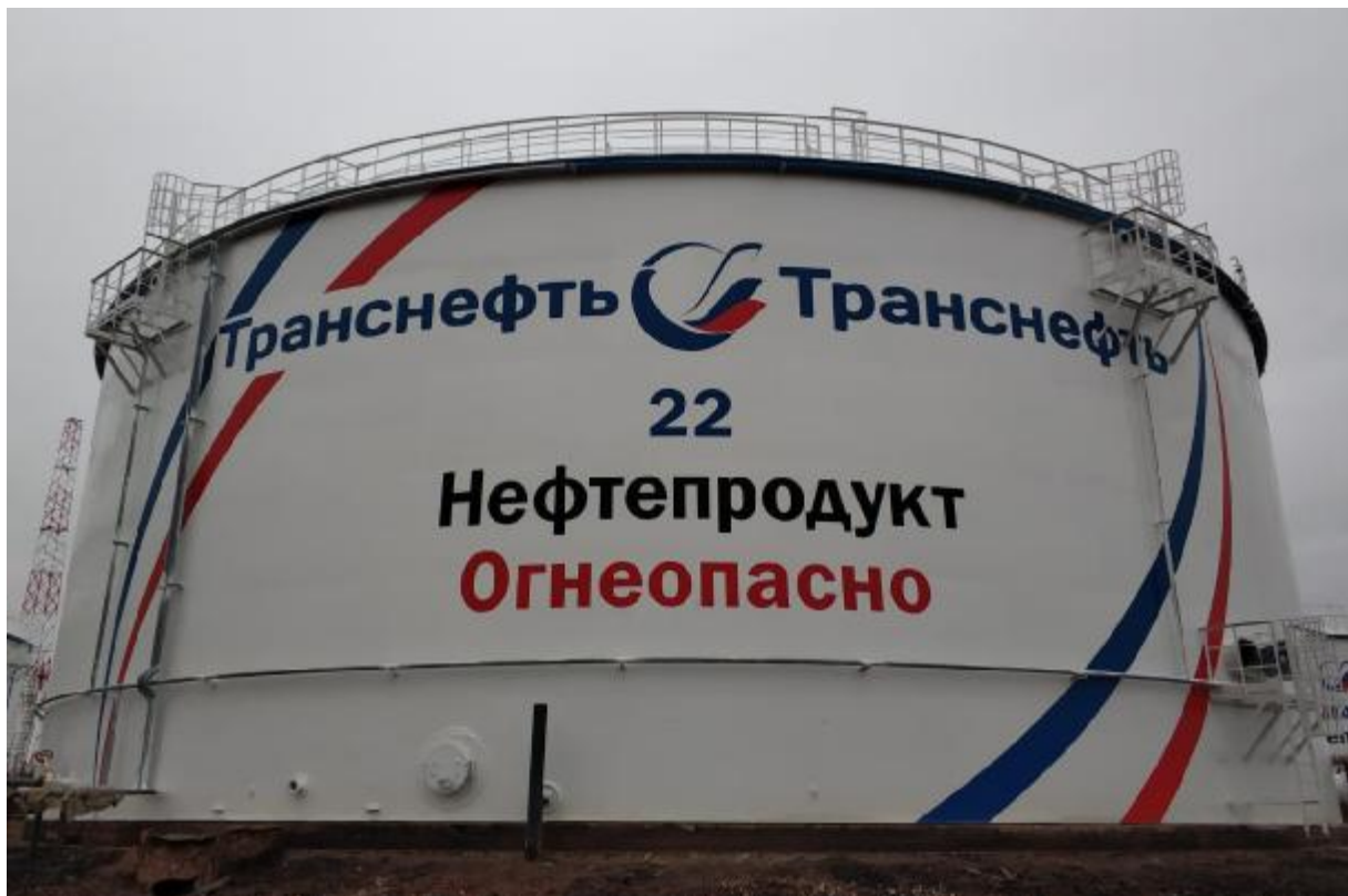
Рисунок 1 – Общий вид резервуара РВСП-10000
