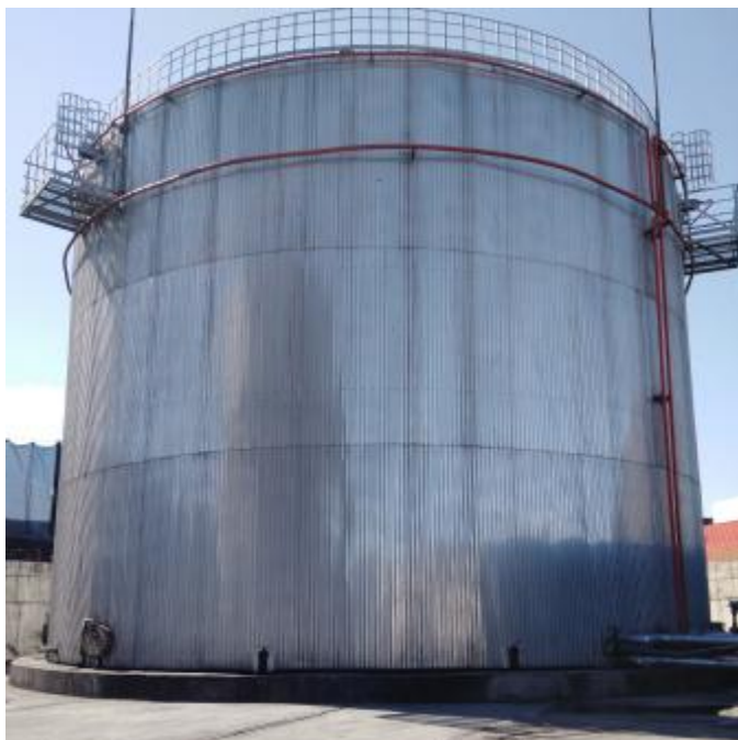
Рисунок 1 – Общий вид резервуара
