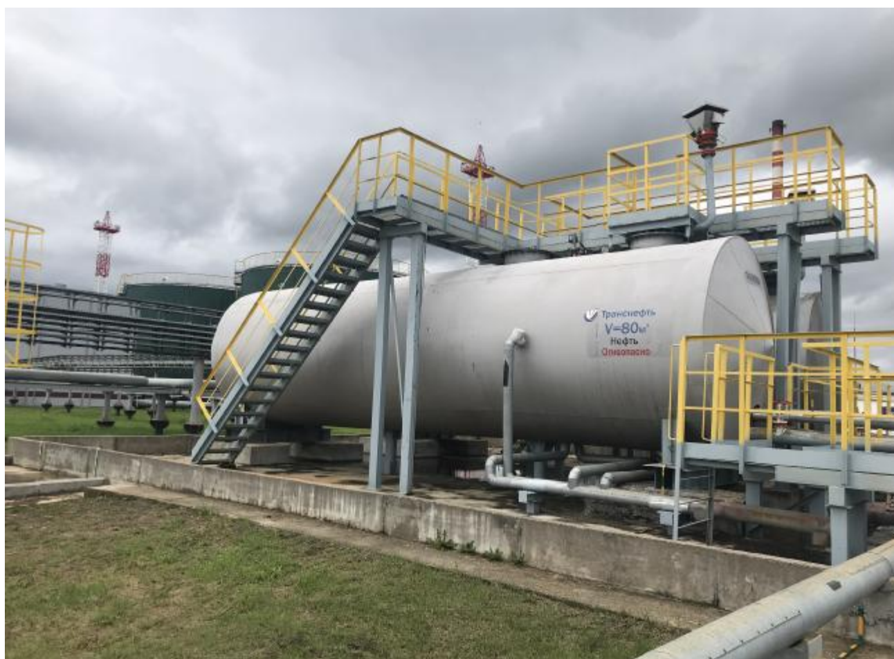
Рисунок 1 – Общий вид резервуара РГС-80
