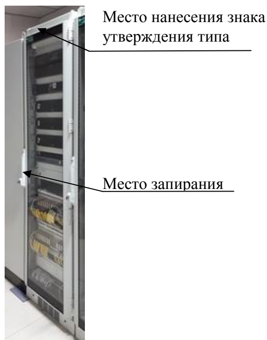
Рисунок 7 – Места расположения наклеек и запирания стойки приборной АИИС
