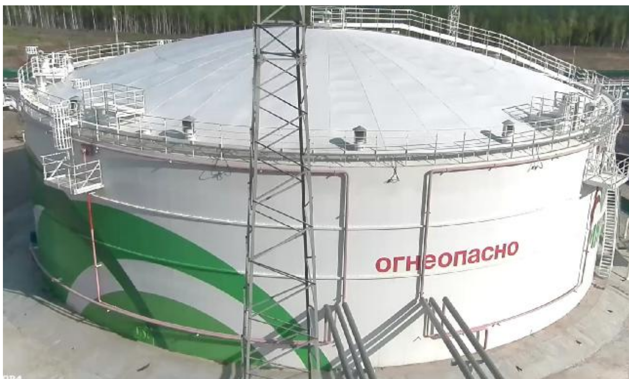
Рисунок 1 – Общий вид резервуара РВСП-20000
