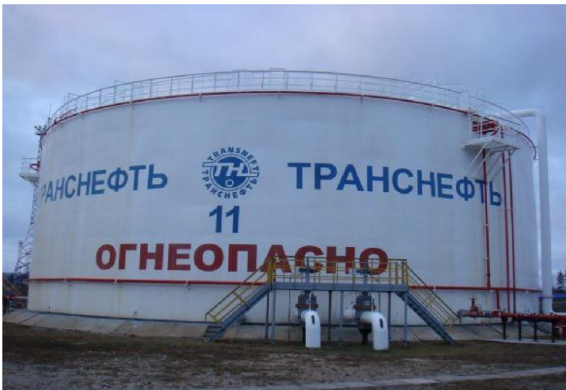
Рисунок 1 – Общий вид резервуара РВС-10000 зав.№ 11
