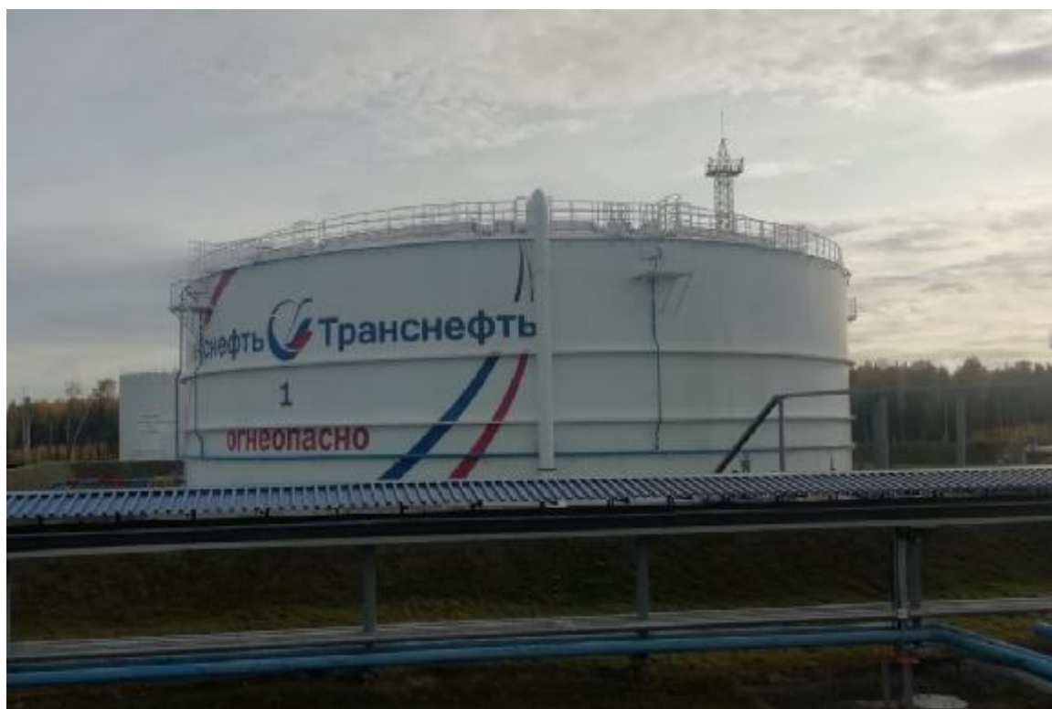
Рисунок 2 – Общий вид резервуара РВС-20000 зав.№ 1
