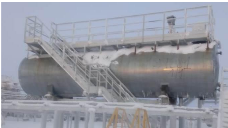
Рисунок 1 – Общий вид резервуара стального горизонтального цилиндрического РГС-50
