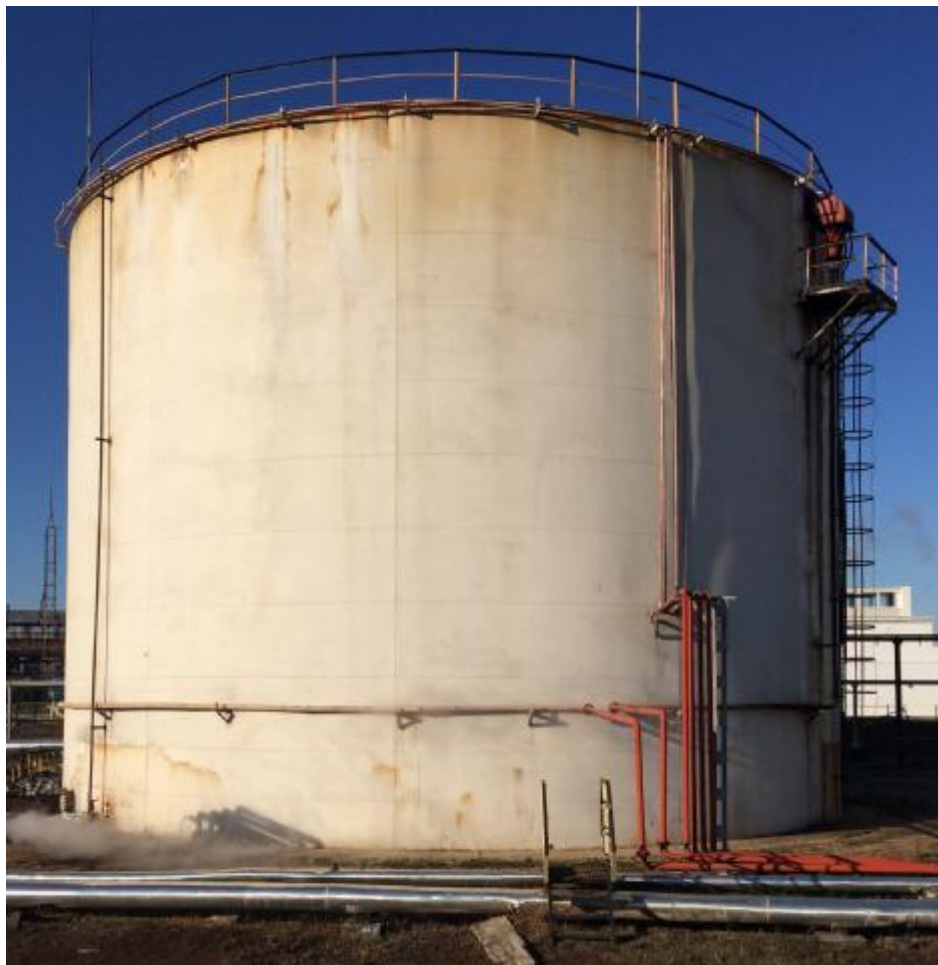
Рисунок 1 – Общий вид резервуара стального вертикального цилиндрического РВС-5000
