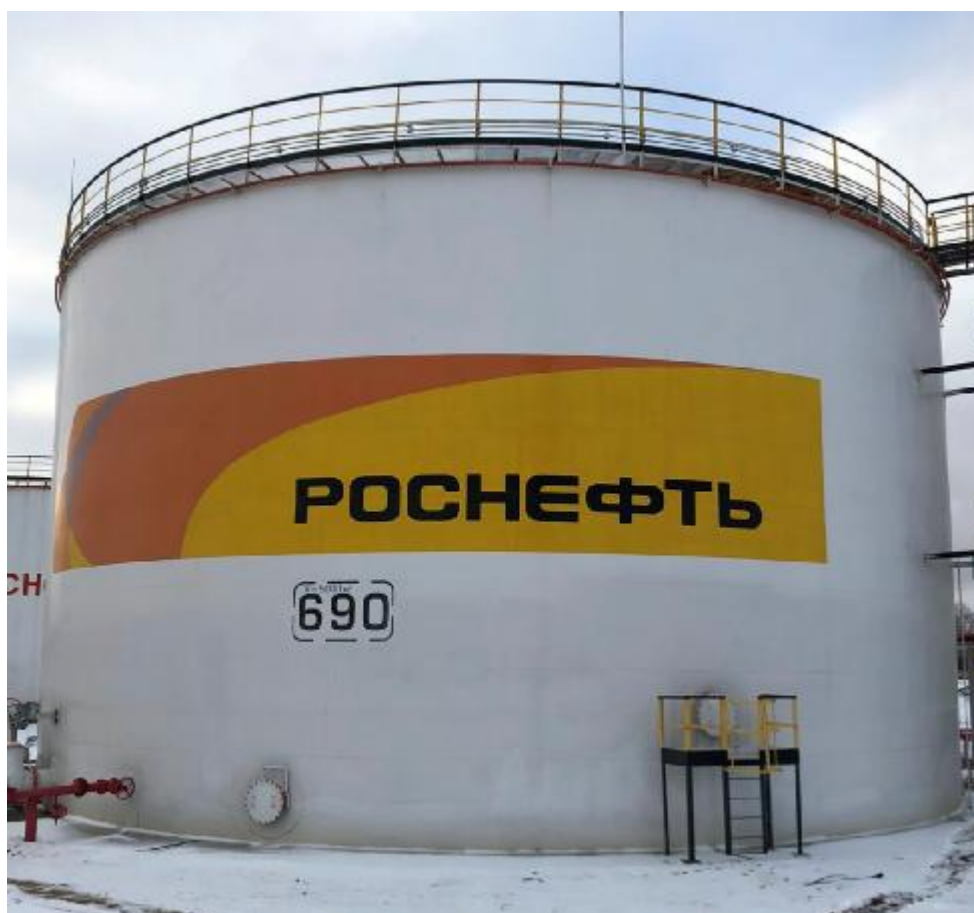
Рисунок 2 – Общий вид резервуара стального вертикального цилиндрического РВСП-5000
