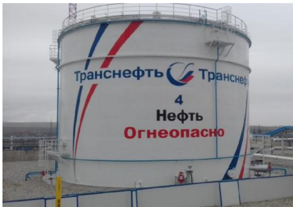
Рисунок 1 – Общий вид резервуара РВСП-5000 зав.№ 4
