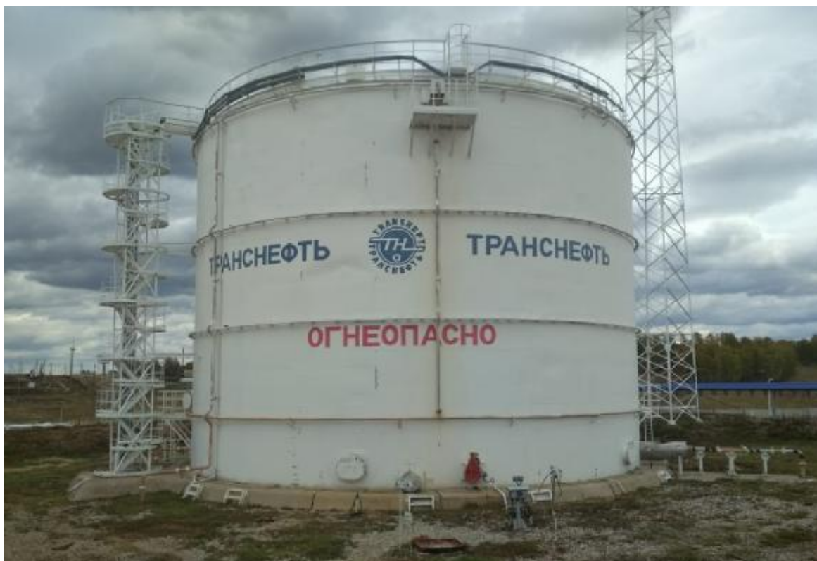
Рисунок 1 – Общий вид резервуаров РВСП-5000 зав.№№ 3, 10, 11, 12
