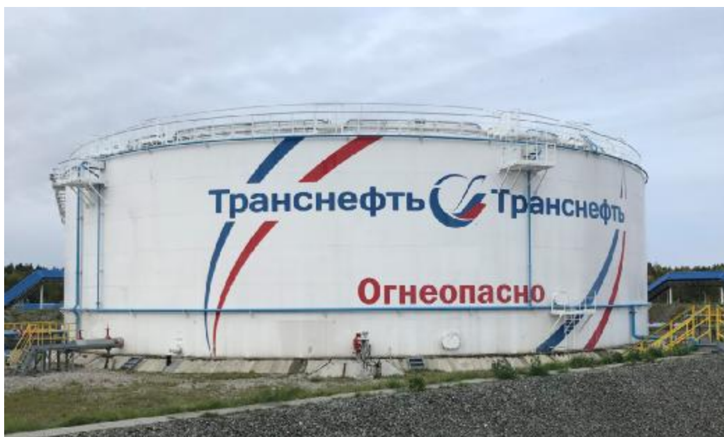
Рисунок 1 – Общий вид резервуаров РВСП-20000 зав.№№ 11, 12
