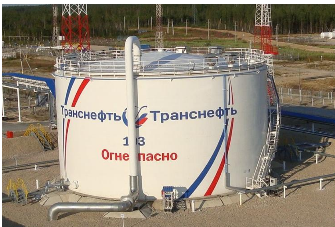
Рисунок 2 – Общий вид резервуара РВС-5000 зав.№ 103
