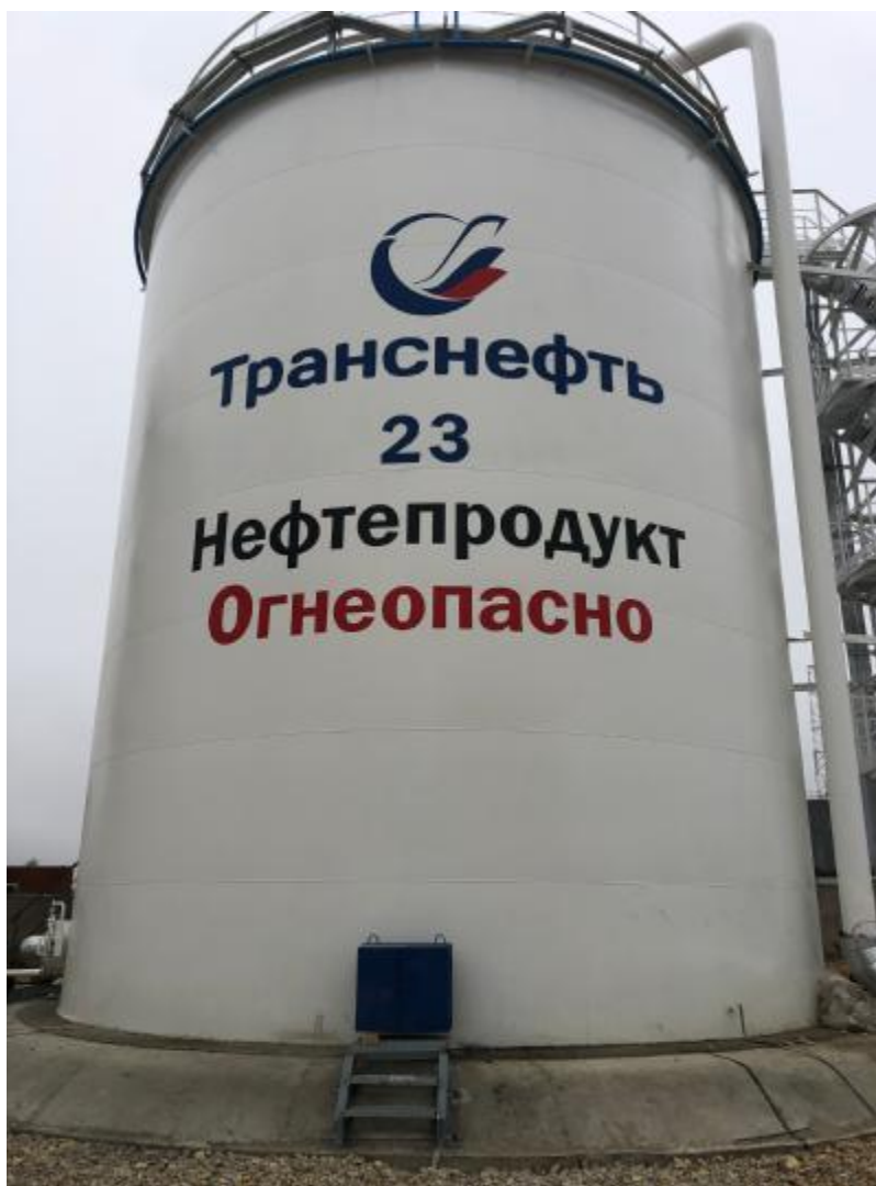
Рисунок 1 – Общий вид резервуара стального вертикального цилиндрического РВС-1000
