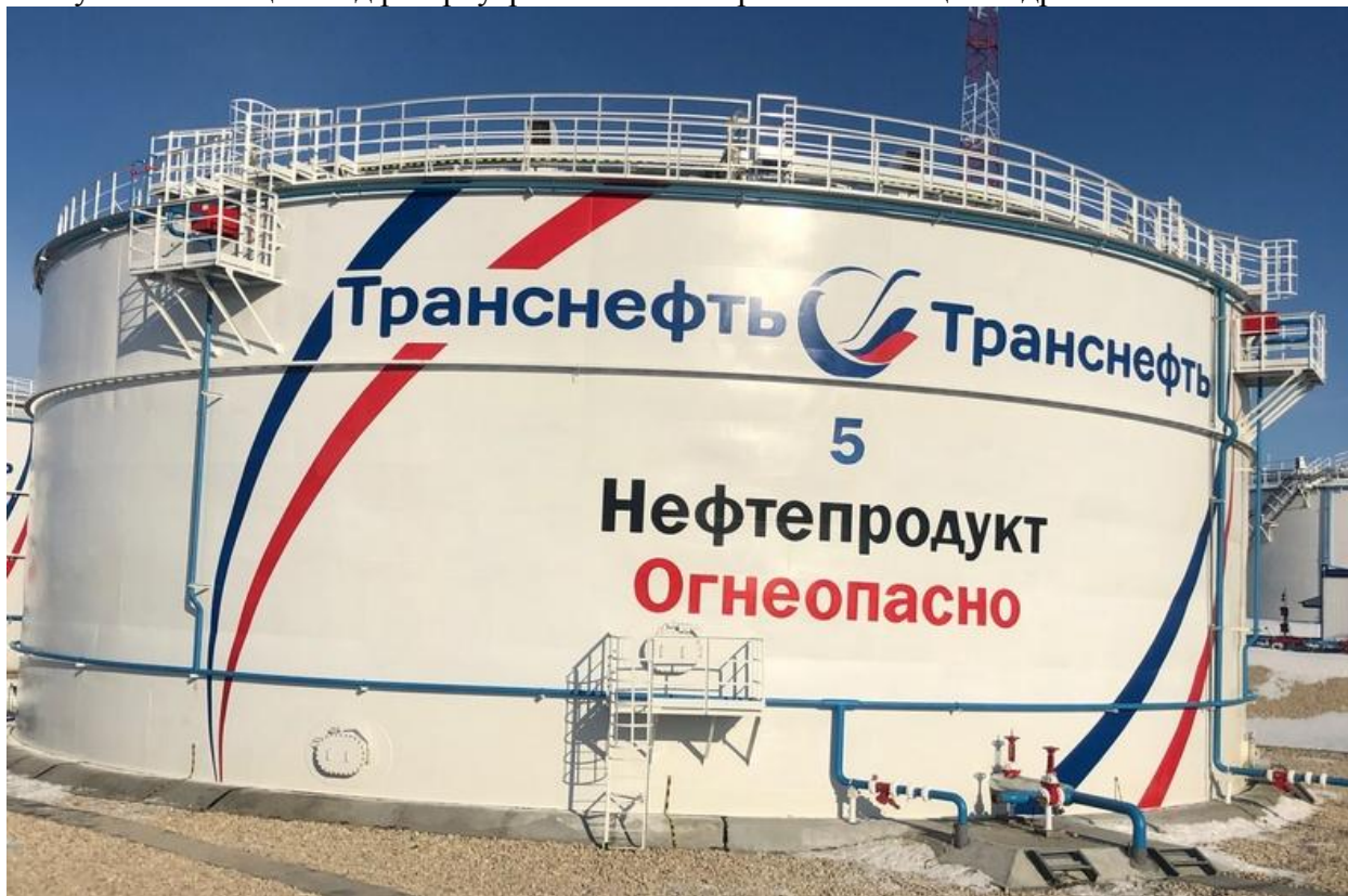
Рисунок 2 – Общий вид резервуара стального вертикального цилиндрического РВСП-10000
