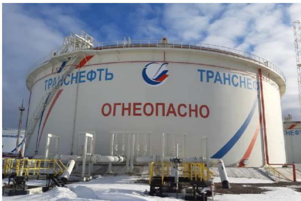
Рисунок 1 – Общий вид резервуаров РВСПК-50000 зав.№№ 13, 14, 18
