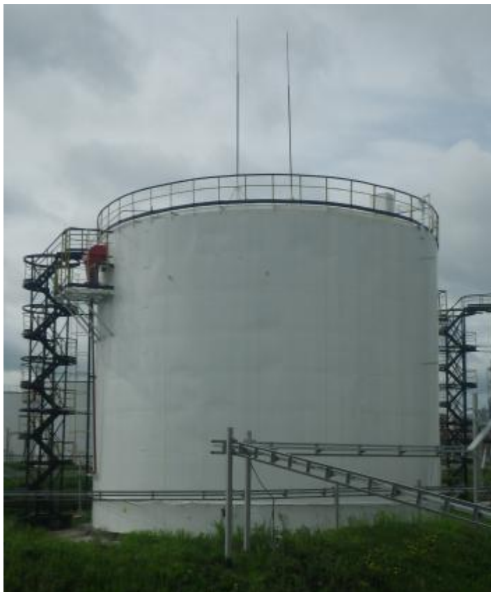
Рисунок 1 – Общий вид резервуаров стальных вертикальных цилиндрических РВС-2000
