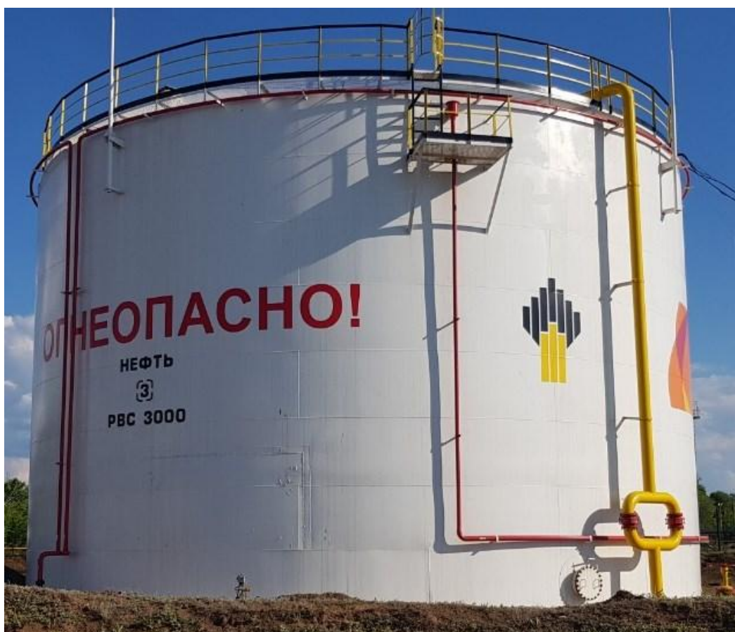
Рисунок 1 – Общий вид резервуара стального вертикального цилиндрического РВС-3000
