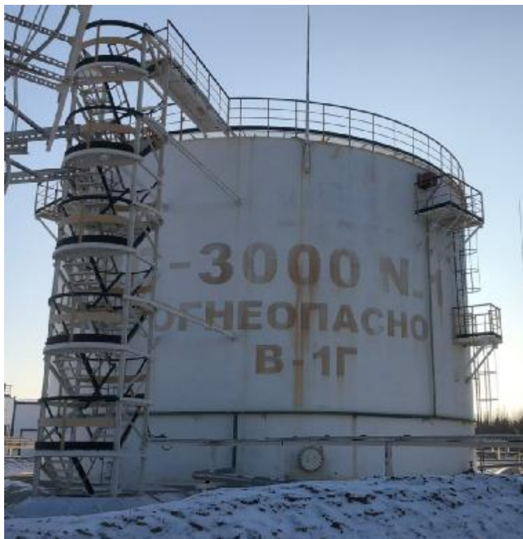
Рисунок 1 – Общий вид резервуаров стальных вертикальных цилиндрических РВС-3000
